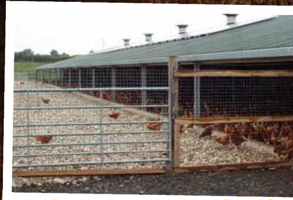
พื้นที่ทางเข้าของหลุมเจาะช่วยลดการรุกรานของพื้นดินและเก็บฟางปูพื้นในโรงเรือนให้แห้ง
